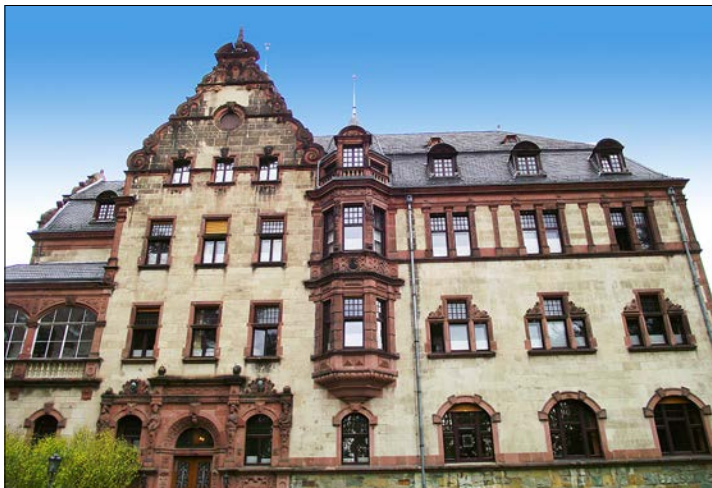
Obr. 1 – budova fyzikálního centra v Bad Honnef
