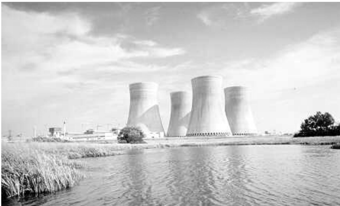
Jaderná elektrárna Temelín
