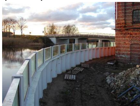
obr. 10: povodňová zábrana – výrobce firma IBS (Německo)
