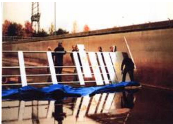
obr. 3: povodňová zábrana – výrobce firma Biber Barriere (Německo)
