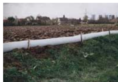
obr. 11: povodňová zábrana – výrobce firma Koexpro Ostrava (ČR)
