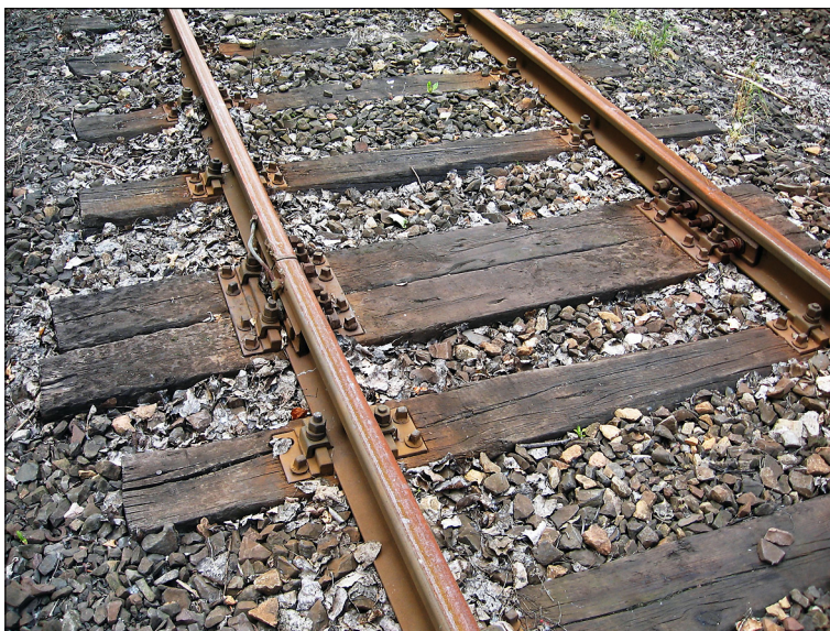
Obr. 1 – železniční pražce a koleje
