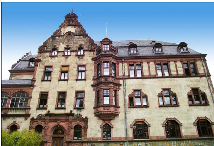
Obr. 1 – budova fyzikálního centra v Bad Honnef
