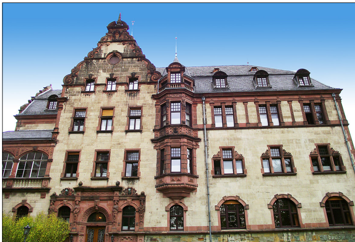
Obr. 1 – budova fyzikálního centra v Bad Honnef
